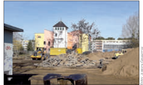
Das Baugelände an der Frankfurter Allee ist planiert. Bald kann die Bodenplatte gegossen werden.
